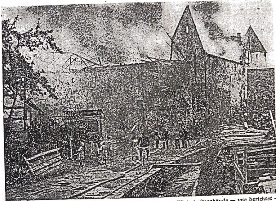
Ein Bild der Verwüstung bietet das Eysöldener Schloß, dessen Wirtschaftsgebäude — wie berichtet — am Montag einem Schadenfeuer zum Opfer fielen. Nur noch die Grundmauern sind übrig geblieben, wie unser Bild zeigt, das während des Großbrands aufgenommen wurde.
