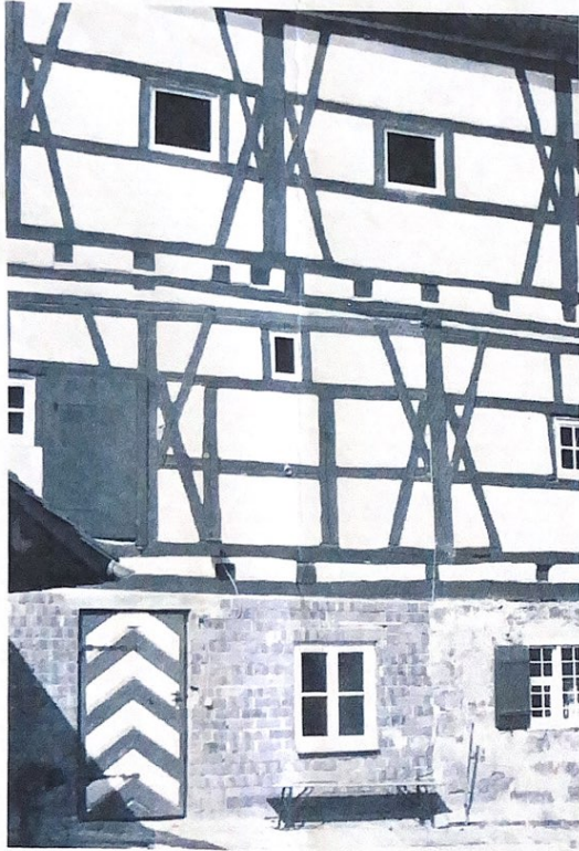
Oben: Freigelegtes Fachwerk im Innenhof des ehemaligen Schlosses Eysölden
